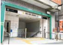
福岡市地下鉄七隈線 薬院大通駅
