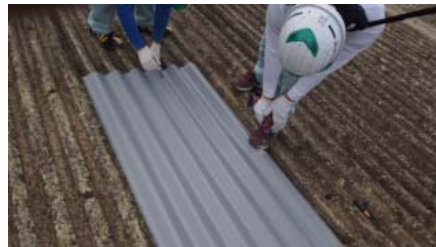
スレート補修
